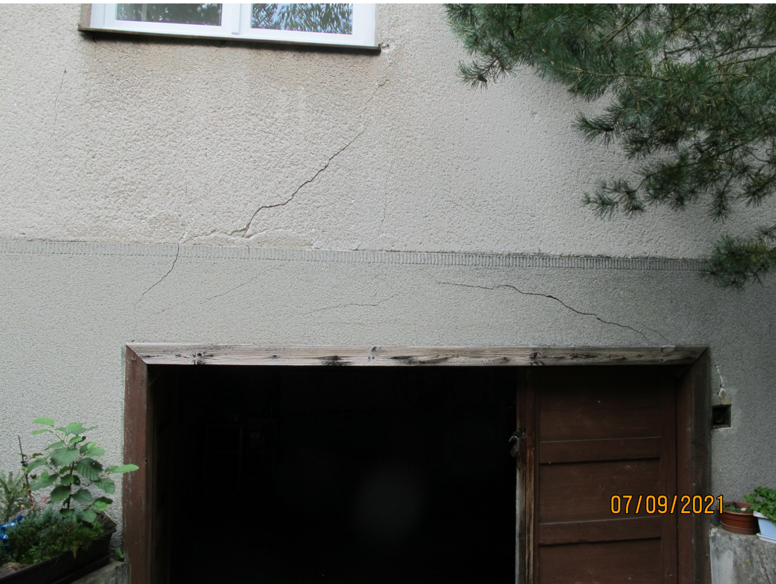
TRHLINY ZNAČÍCÍ POKLES PŘEKLADU
