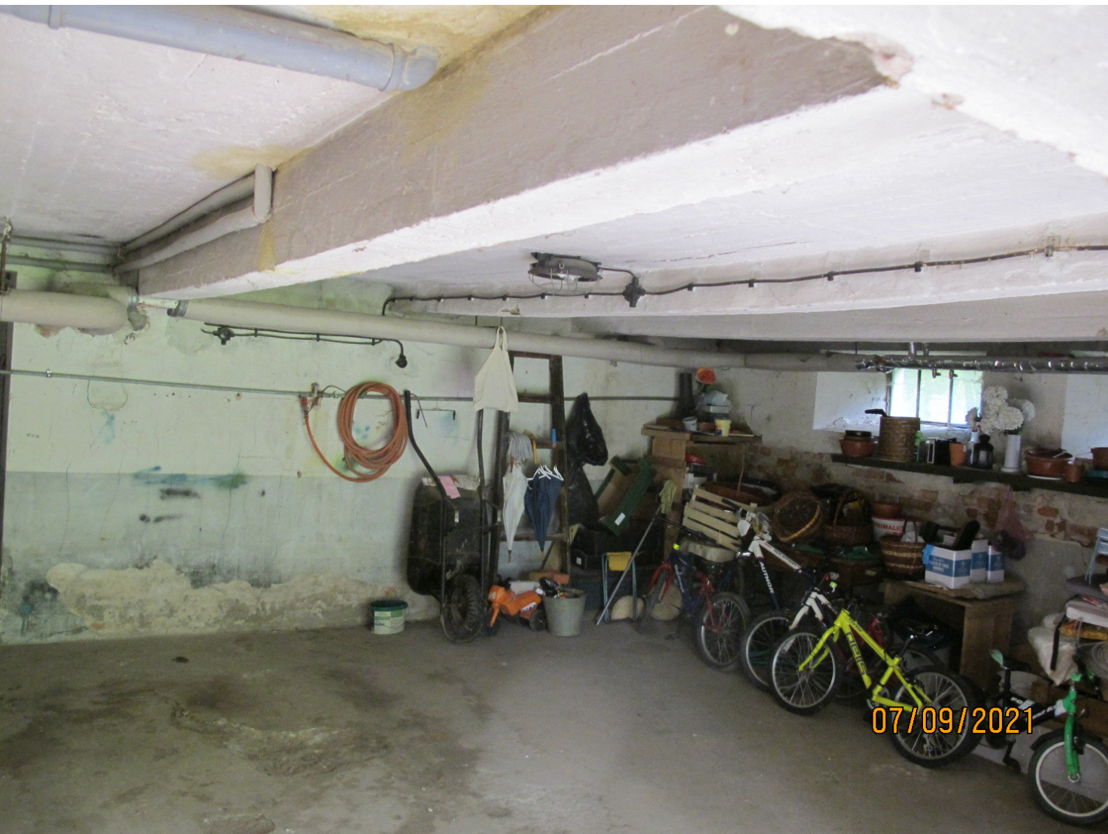
VIDITELNÁ DEFORMACE STROPNÍ KONSTRUKCE
